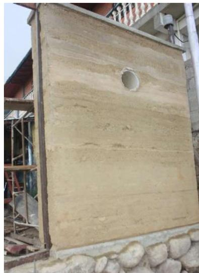
Figura 3. Resultado preliminar para pruebas del encofrado y composición de tierras en muro.
