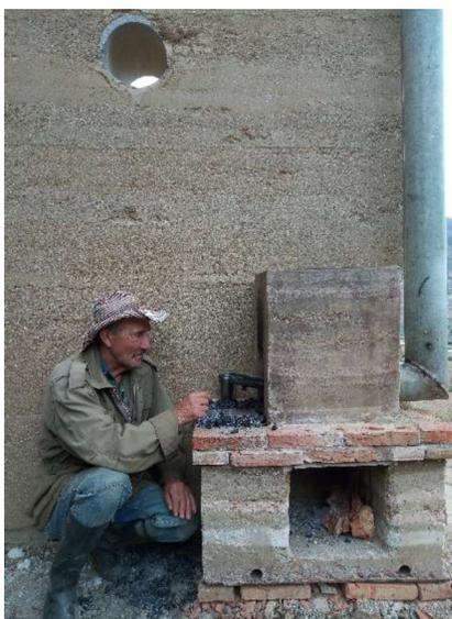
Figura 4. Módulos prefabricados de tapia para estufa y porta leña. Ubicación: La Toma de Mucuchíes, Municipio Rangel, Mérida
