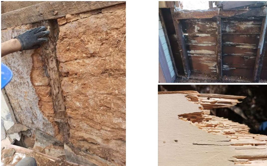
Figura 2. Pie derecho presenta pérdida de sección en muro de adobillo de primer piso; Muro de segundo piso afectado por humedad por transmisión lateral y carente de aislante; afectación por xilófagos en madera de cerramiento (crédito: Cíclica<sup>1</sup>)
