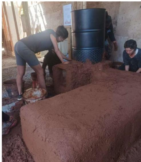
Figura 6. Taller de estufa de masa térmica tipo rocket (crédito: Cíclica)
