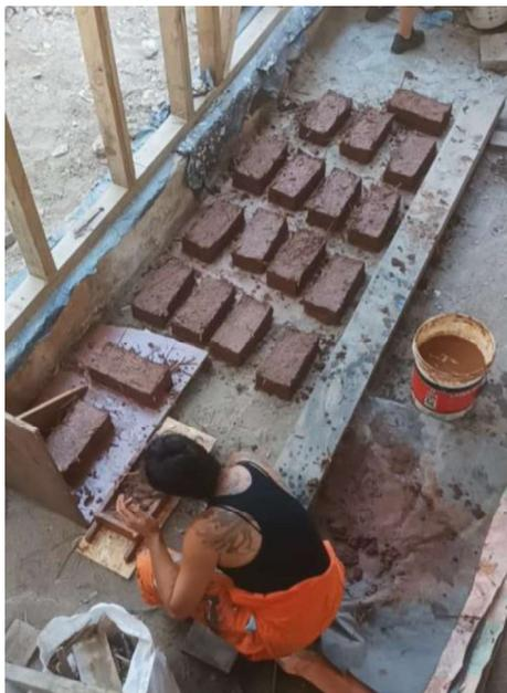
Figura 3. Práctica de fabricación de adobes dentro del taller de técnicas constructivas de bajo impacto ambiental (crédito: Cíclica)
