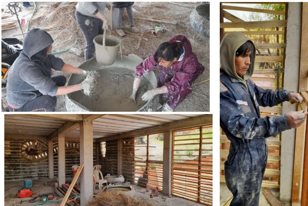
Figura 6. — Izq. Arriba. Mujeres en espacios de dialogo al preparar la fibra embarrada. Izq. Abajo Avance del segundo ayni taller. Der. Maestro Natalio realizando los detalles en el entramado de la quincha y donde se ve el marco de madera fijado a la estructura de hormigón armado
