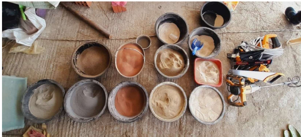
Figura 7. – Preparación de las tierras de colores para los revoques decorativos
