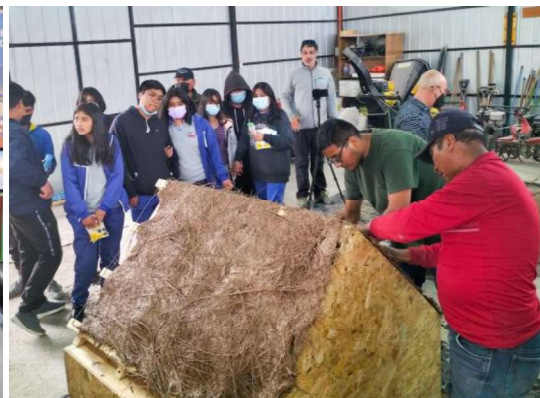
Figura 5. Demostración a escala del proceso constructivo de la caruna a los estudiantes (crédito: J. Cohen)
