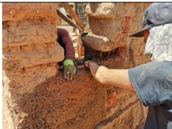
Proceso de rehabilitación de viviendas tradicionales de adobe de la costa de Chiapas, México, en colaboración con Colectiva Bioreconstruye Chiapas, marzo a abril 2021
