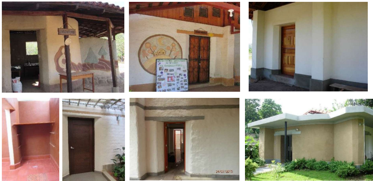
Figura 6. Proyectos en los que se ha incorporado el uso del adobe ochavado para hacer jambas en chaflán para las puertas
