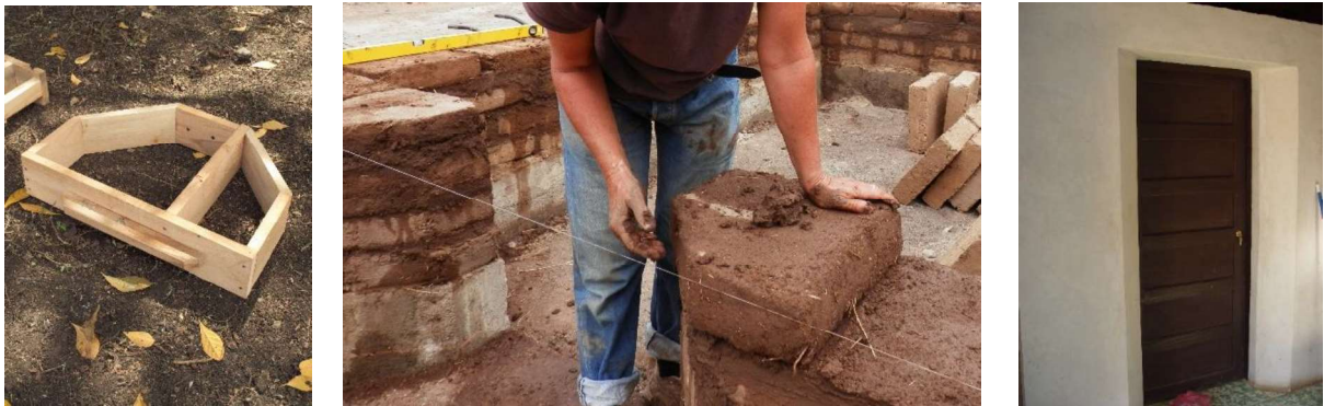
Figura 5. Izquierda: molde o gradilla para adobe ochavado entero y medio. Centro: colocación de adobes ochavados en una pared. Créditos: la autora. Derecha: puerta ochavada de Pueblos Unidos (Créditos: Pascal Chaput)
