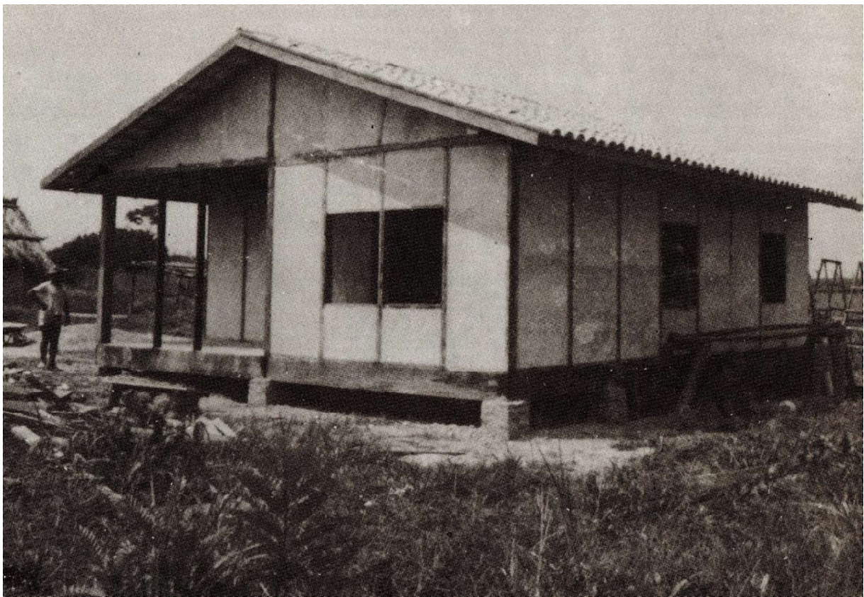
Figura 4 - Habitação rural construída com taipa pré-fabricada na região de Carajás (Pará) (MEC/SG/CEDATE, 1988).
