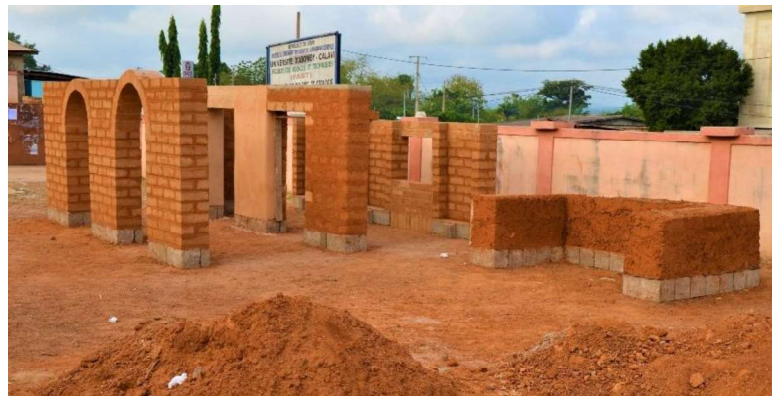
Figura 2. Muretes demostradores de las técnicas de BTC, adobe, tierra modelada y revoques, contruidos durante la formación (crédito: H. Gasnier)
