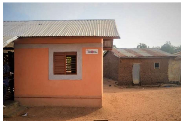
Figura 6. Centro de actividades económicas, de energía y de transformación de soya, construido en adobe y tierra moldeada
