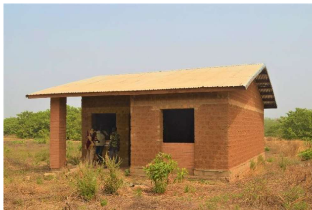
Figura 4. Prototipo pedagógico de vivienda rural construido en mampostería portante de adobe, muros de antepecho y pilar en BTC. La foto es antes de los revocos
