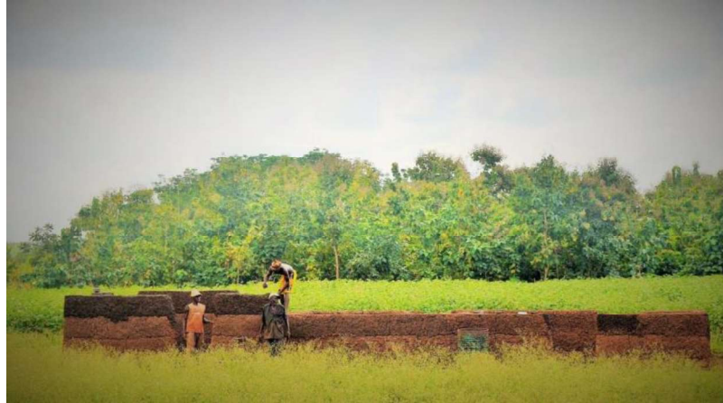
Figura 1. Ejemplo vivo y actual de la arquitectura vernácula. Construcción de una casa en tierra moldeada en la región de colinas en Benín
