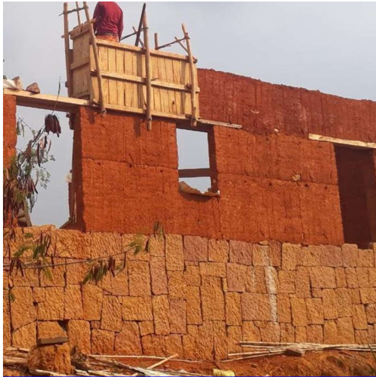
Figura 2. Aprendizaje colectivo de la técnica de la tapia pisada en Barichara (Gélvez, 2020)
