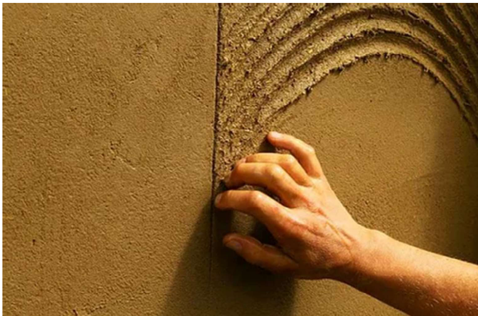
Figura 3. Pañete de cagajón (Saberes Patiamarillos Barichara, sf)
