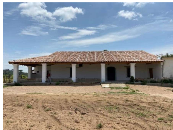
Figura 3. Hacienda el Álamo, después de ser intervenida
