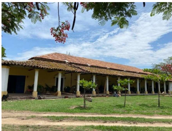
Figura 4. Hacienda Llano Grande, después de ser intervenida la cubierta de cruja central
