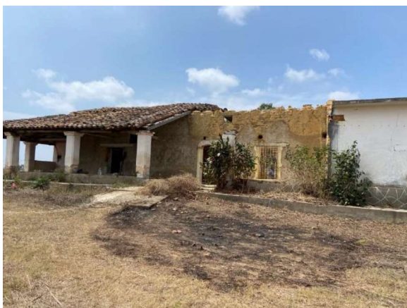
Figura 2. Hacienda el Álamo, antes de ser intervenida
