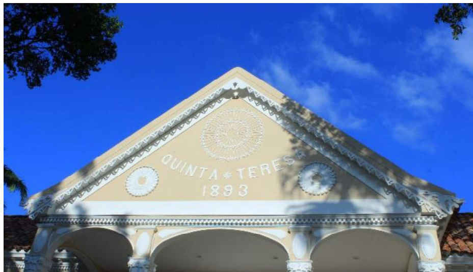
Figura 8. Muro de fachada en bahareque pañetadas y decoradas con molduras en mortero de cal, arenilla y yeso, detalles de madera y molduras metálicas
