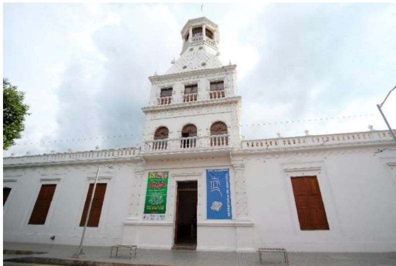
Figura 1. Casa Torre del Reloj muros inferiores en ladrillo cocido pañetado con mortero de cal y arenilla, cuarto piso de la torre de principio del siglo XX en bahareque (Crédito: Sebastián Delgado Caicedo)
