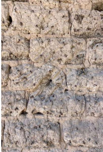
Figura 4. Construcción con terrón, Belén, Nuevo México
