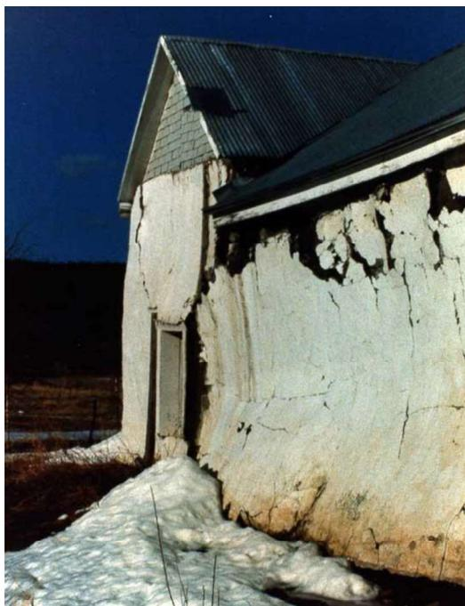
Figura 5. Daños ocasionados por la aplicación de revestimientos con cemento Portland, Capilla de San José, Rociada Arriba, NM (Cornerstones, 1986)
