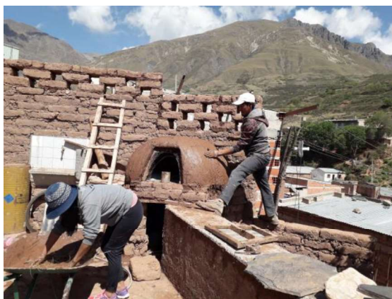
Figura 4. Realizando la guaya en un horno de barro en Nazareno
