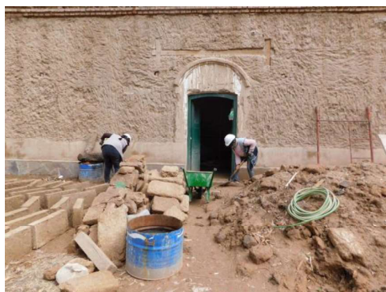
Figura 3. Tareas de preparación para el corte de adobes en Yavi
