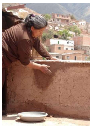
Figura 2. Milagro, pobladora de Nazareno arreglando el revoque del muro
