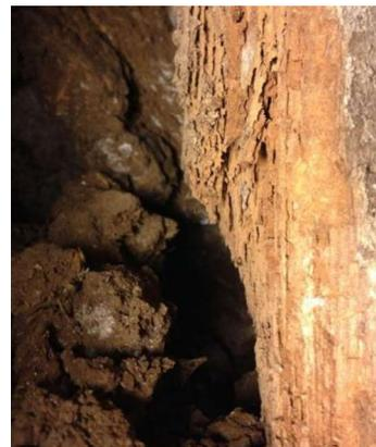
Fig. 5c pudrición de madera - revestimiento de cemento
