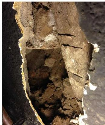
Fig. 5b humedad retenida por revoque de cemento
