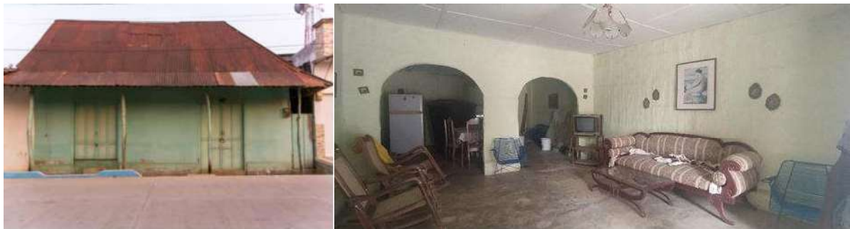
Figura 4. Vivienda de bahareque en el sector histórico de Sucre. El aterrado de la vía ha alterado la altura del zócalo y del corredor (UNAL, 2022)
