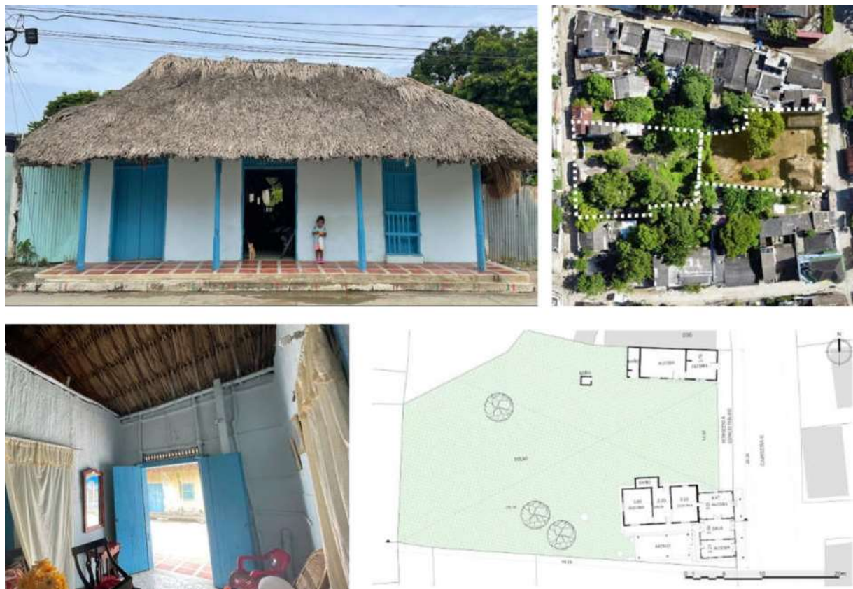
Figura 2. Vivienda tradicional de bahareque y palma en Santiago de Tolú. En la aerofotografía de la manzana se observa la relación de 2 viviendas tradicionales y sus patios (UNAL, 2022)
