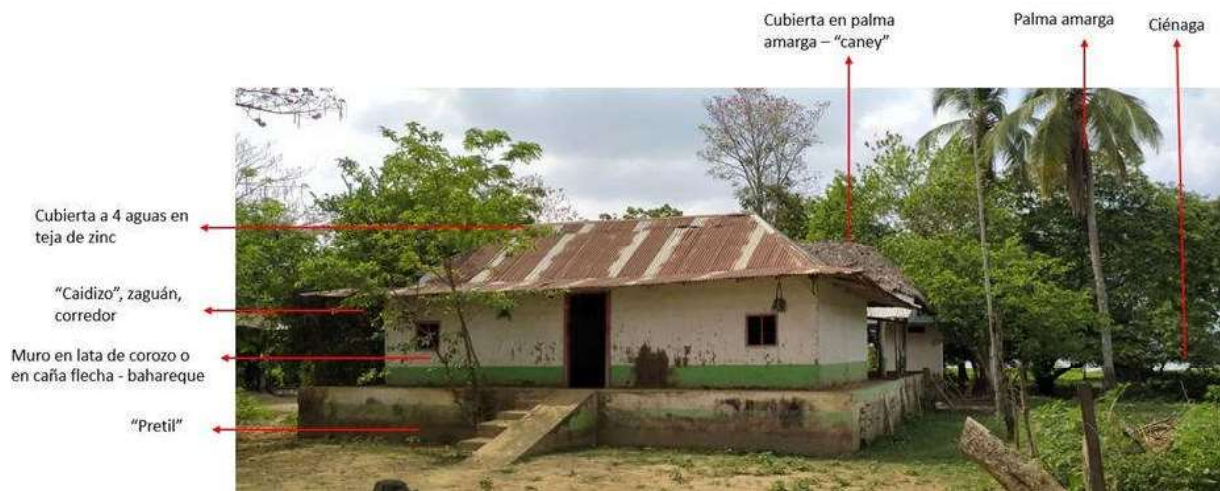
Figura 3. Vivienda rural en bahareque "lata" de corozo en el corregimiento de Quitasueño (UNAL, 2022)
