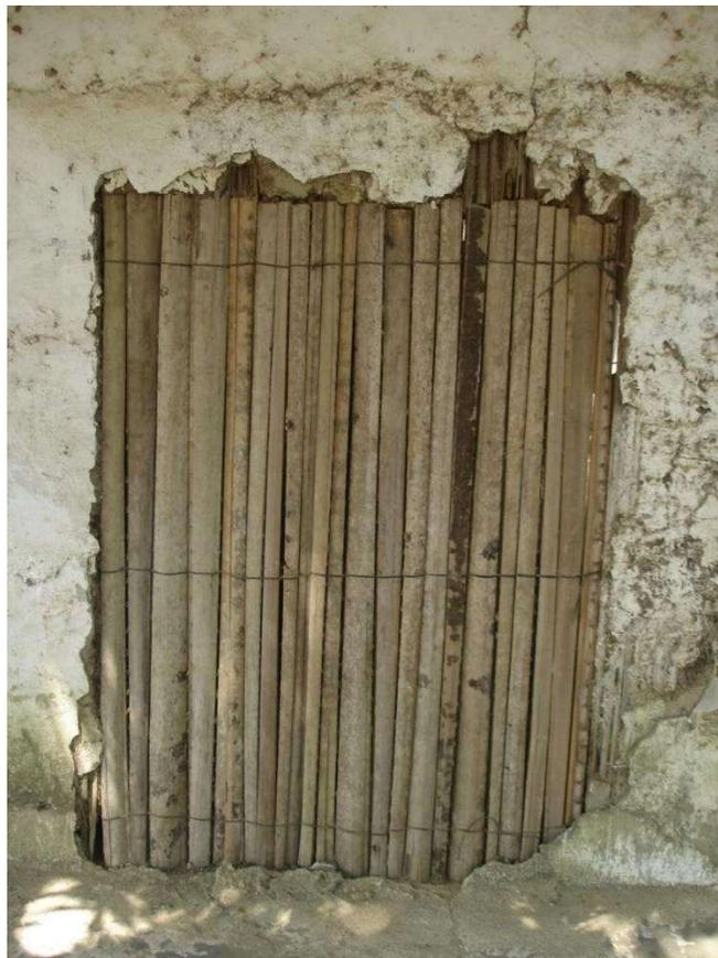
Figura 4. Alma de ramas del muro de una casa localizada en San Antero
