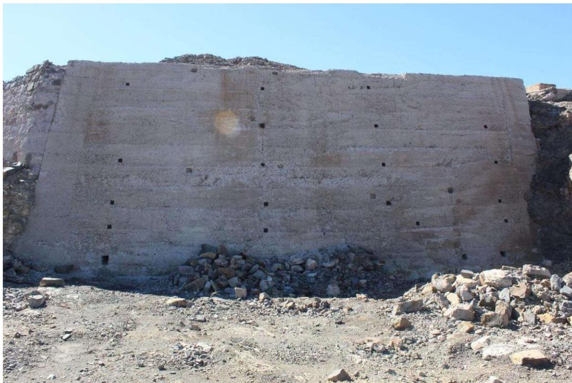
Figura 6. Muro contención de hormigón en masa con injertos metálicos
