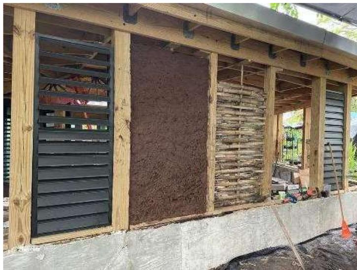
Figura 6. Residencia Hábitat Semilla en construcción. Pared con entramado en bambú primera capa de revoque en tierra
