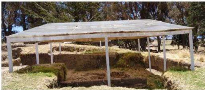
Figura 2. Vista general de la estructura de madera con techado de policarbonato, haciendo un impacto visual importante en el paisaje. Al fondo se puede ver el perfil de excavación colapsado
