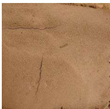
Figura 6. Prueba dosificación de revoque fino
