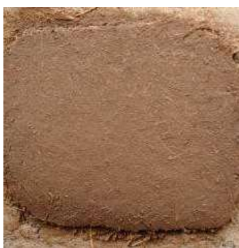
Figura 5. Prueba dosificación de revoque grueso
