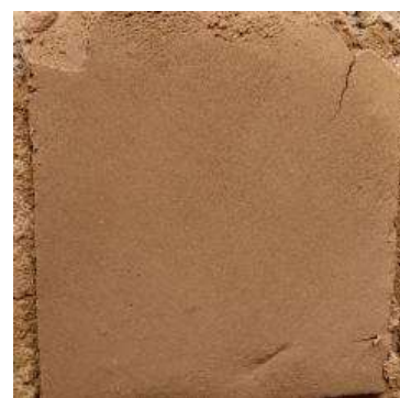
Figura 7. Prueba dosificación de revoque fino
