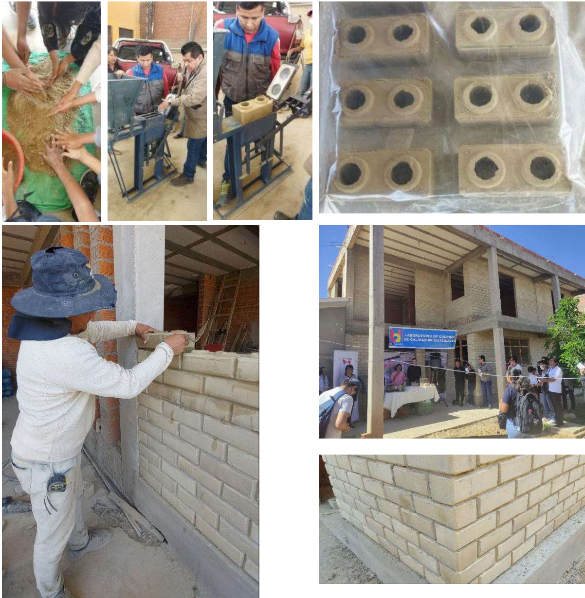
Figura 8 – Producción en serie del BTC asumido para la construcción de la vivienda
