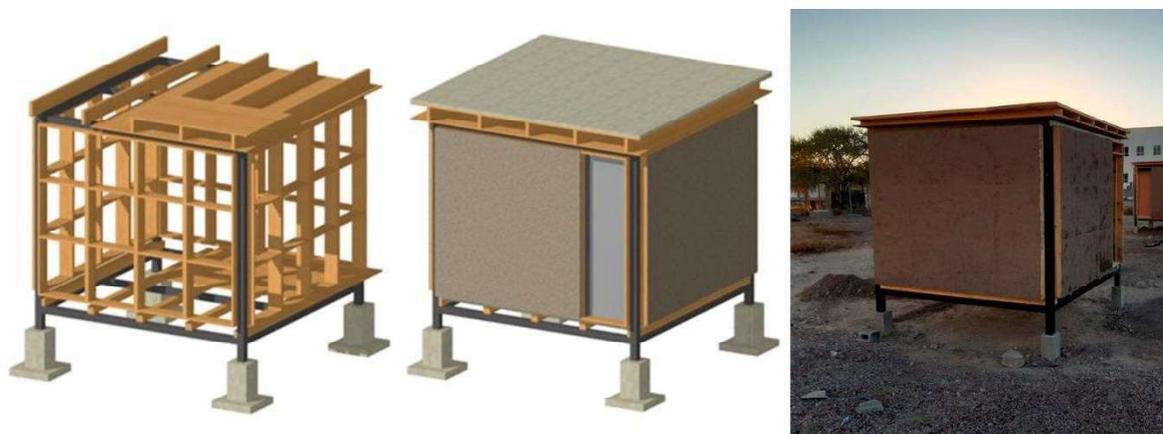
Figura 2. Sistema bajareque tecnificado edificado en la Universidad Autónoma de Coahuila, Unidad Torreón, México
