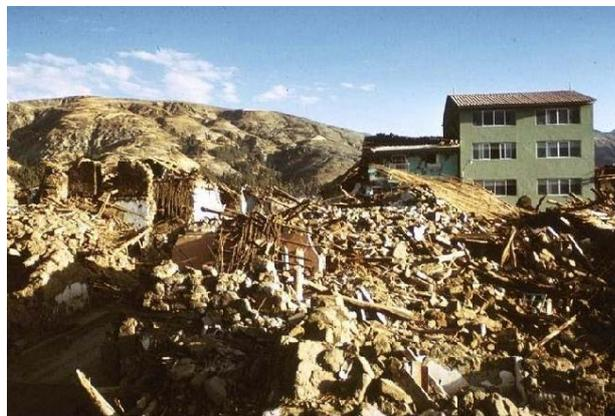
Fig. 1 – Colapso total de viviendas de tierra.
