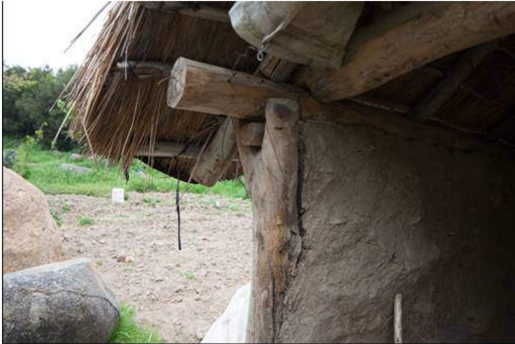
Figura 14. Detalle de la estructura mixta en esquina (Crédito: Marcos Zegers)
