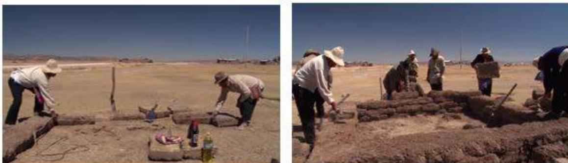
Figura 8 – Inicio del proceso constructivo del putuco
