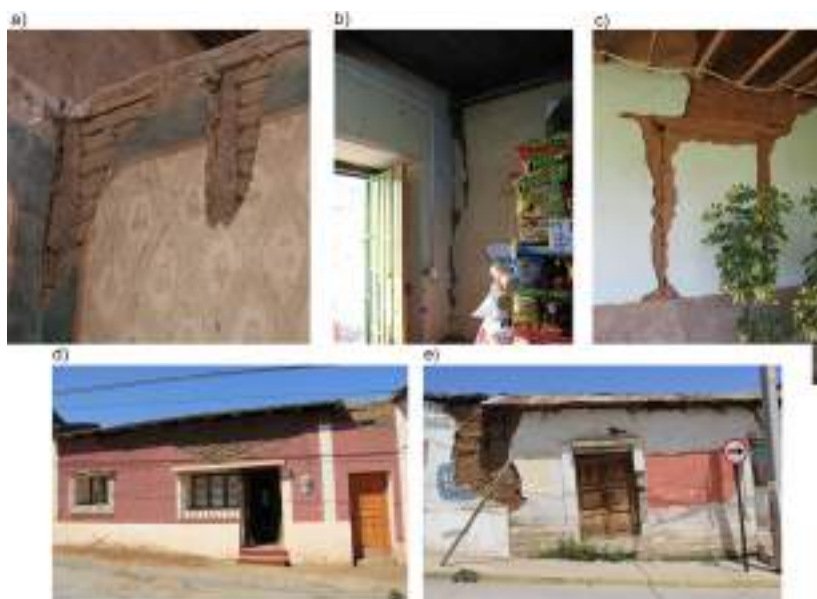
Figura 7. Tipos de daños leves presentes en Canela. Evaluación de daños a los diez días del sismo (Créditos: Amanda Rivera y Cristian Muñoz en 2015)
