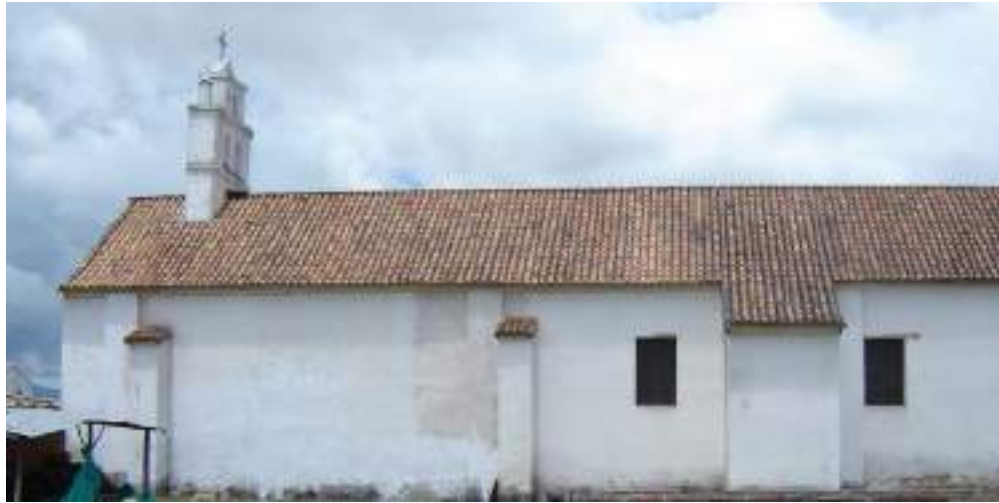
Figura 5. Fachada lateral de la iglesia de Oicatá Boyacá exhibiendo los estribos especificados originalmente, 2009
