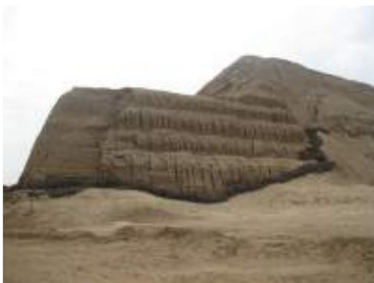
Figura 1. Huaca del Sol – edificio piramidal construido íntegramente en adobes pequeños
