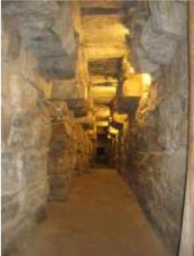
Figura 5. Ménsulas de soporte del techo en una galería en Chavín de Huántar
