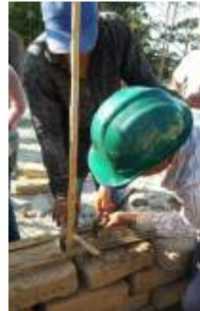
Figura 5. Colocación de refuerzo horizontal.
