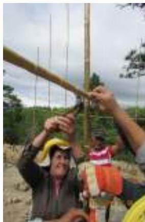
Figura 7. Colocación de refuerzo vertical
