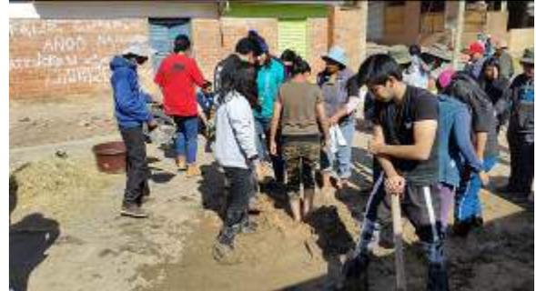
Figura 17: Estudiantes pisan el barro para la aplicación del revoque en el muro perimetral
