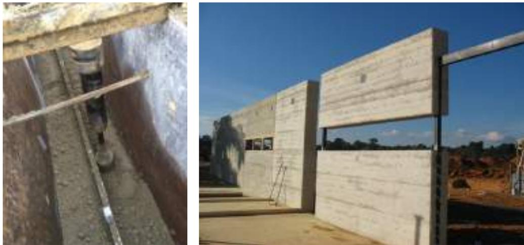
Figura 8. Execução de taipa de pilão sobre viga metálica em “T” e colunas metálicas embutidas, 2014
