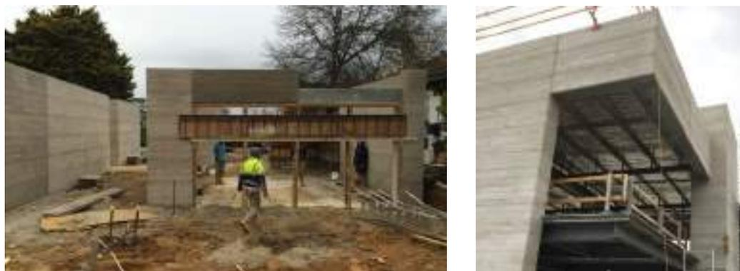
Figura 9. Exemplos de execução de vigas de taipa acima de vigas metálicas em “T”, 2015
