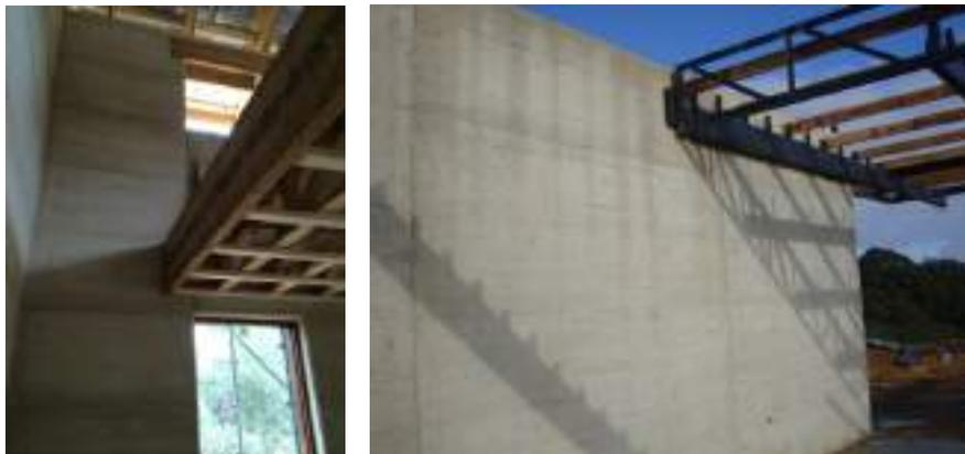
Figura 7. Exemplos de conexões de piso em madeira e viga metálica para cobertura, 2014 (Créditos: Oliver Petrovic)
