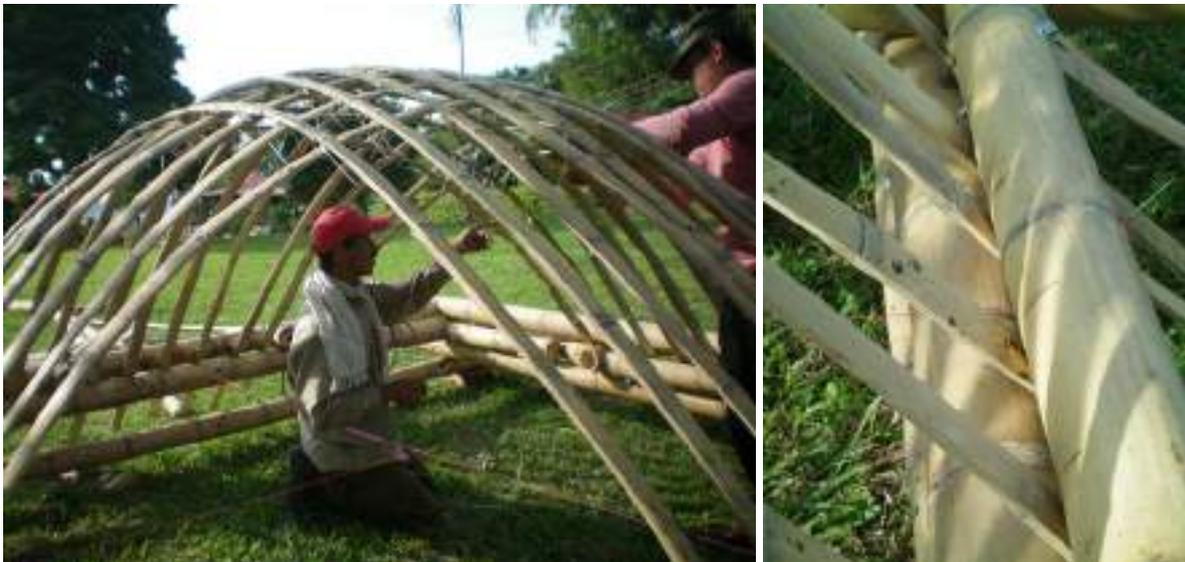
Figura 5. Elaboración de domo caña con latas de guadua para el revestimiento de cubierta con tierra y cal, 2017 (Créditos: L. Garzón)
