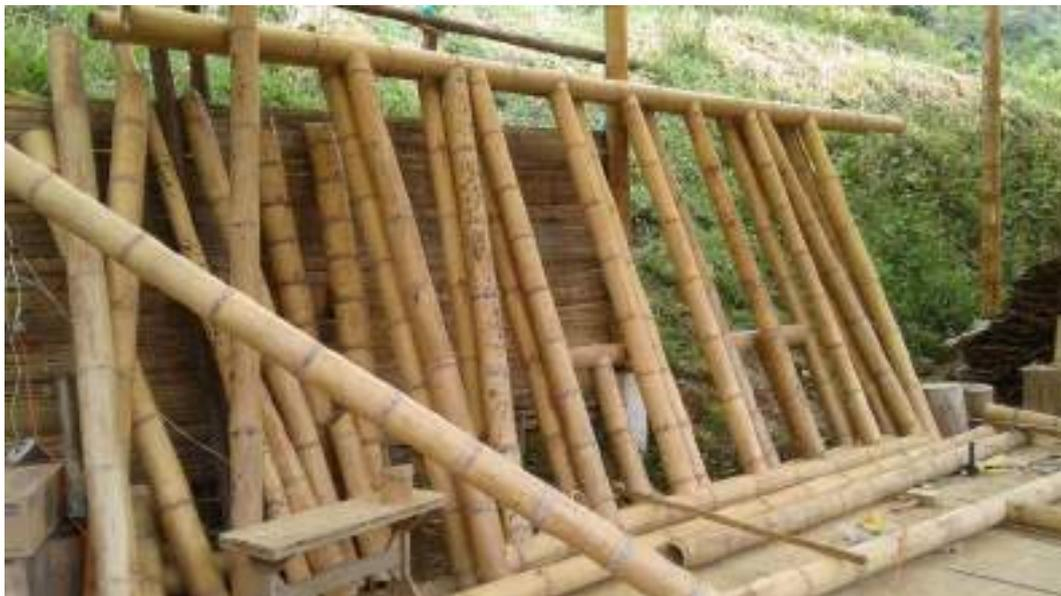
Figura 3. Estructura prefabricada técnicamente con guadua, 2017 (Créditos: L. Garzón)
