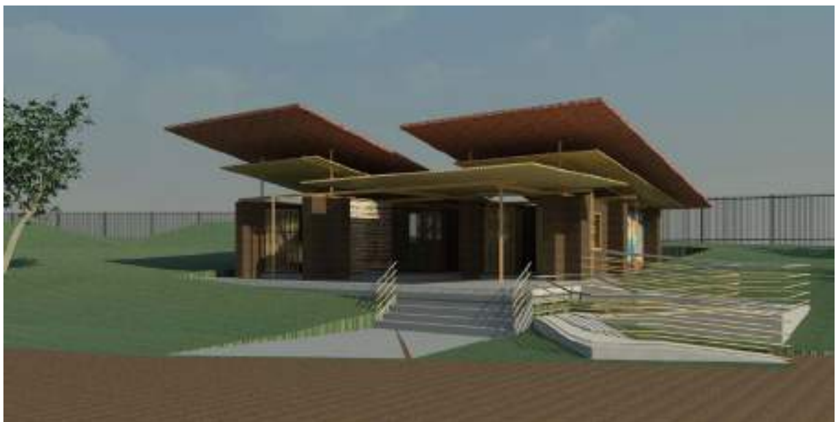
Figura 4. Vista frontal de módulo de aulas. Combinación de técnicas, adobe y bahareque con revocos expuestos y artísticos. Cubierta con cámara de climatización en bambú.
