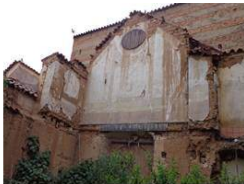
Figura 4. Vista actual de muros originales de lo que fuera la capilla de Indios en el Manzano Jesuítico
