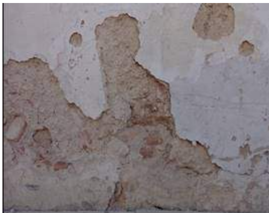
Figura 5. Vista actual muro exterior parroquia San Miguel
