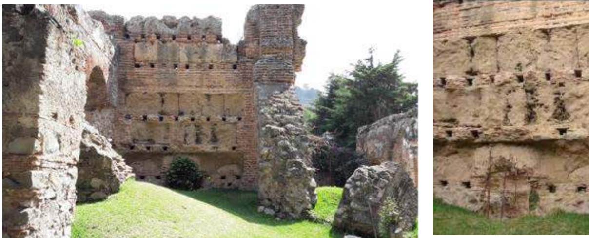
Figura 4. Detalle de muro de tapial con rafas de ladrillo del Convento de San Francisco (Créditos: Lucía Carrera)
