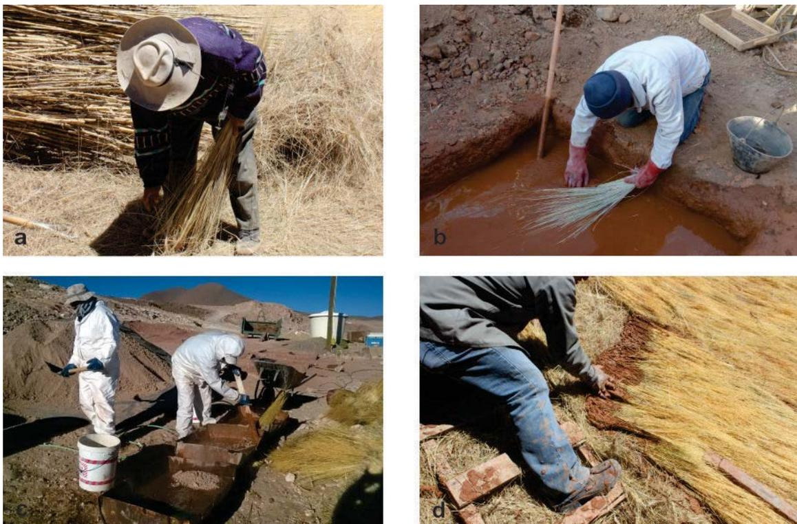
Figura 3. Distintos momentos en el proceso de repaje en los casos analizados: (a) Cochinoca, preparación de la paja; (b) Coranzulí, armado de los manojos; (c) Conchi Viejo, mezclado del barro; (d) Caspana, colocación en el techo (Fotografías propias)
