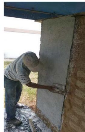
Figura 5. Colocación de segunda capa de repello
