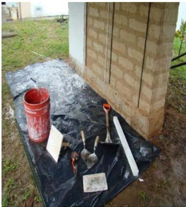
Figura 1. Herramientas utilizadas para la elaboración de repellos
