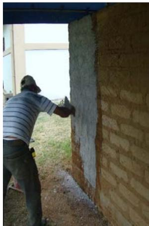
Figura 4. Colocación de primera capa de repello
