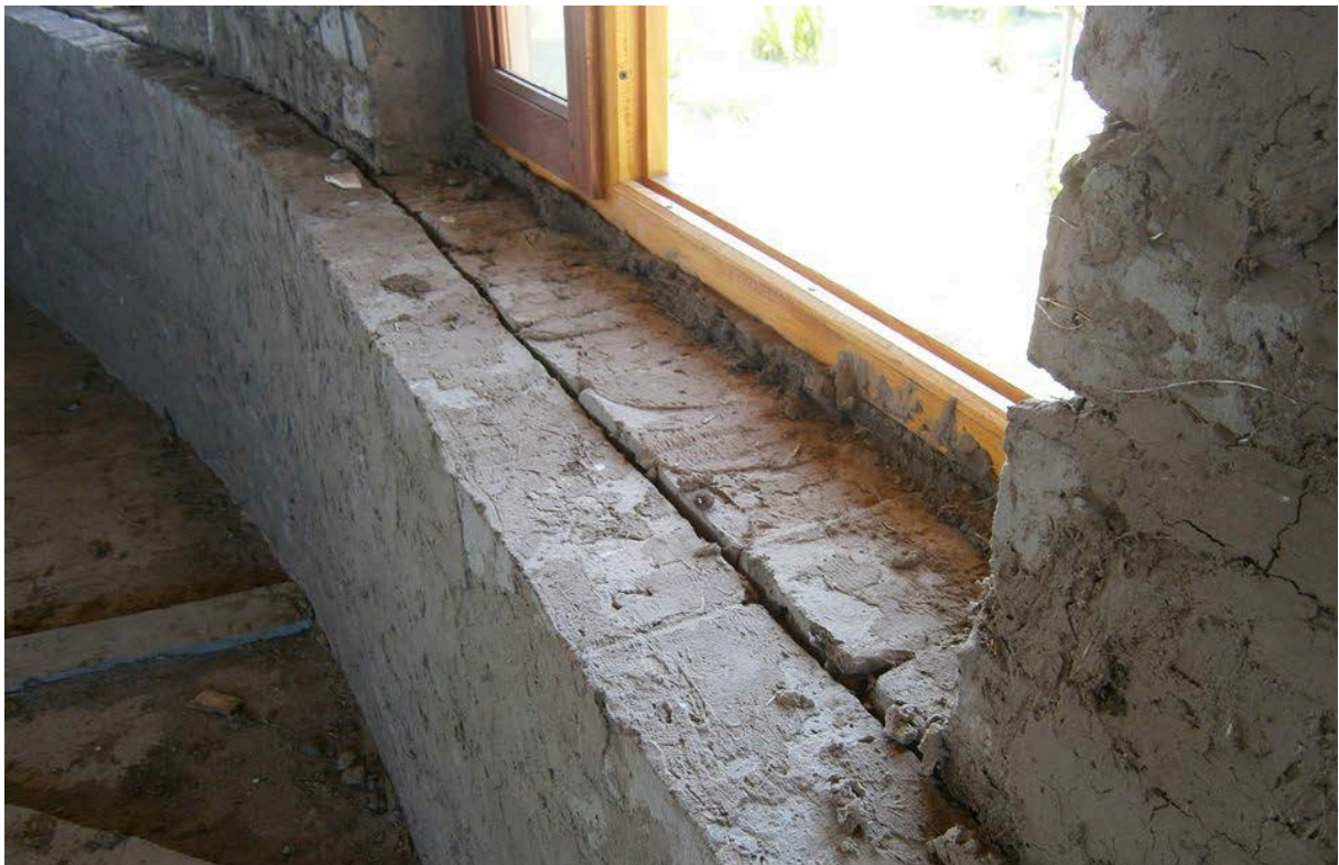
Figura 3 – Muros dobles en plena ejecución. Obsérvese la fina cámara de aire
