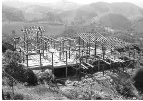
Construcción en estructura de eucalipto citrodora autoclavado y cerramiento en pau a pique y adobe
