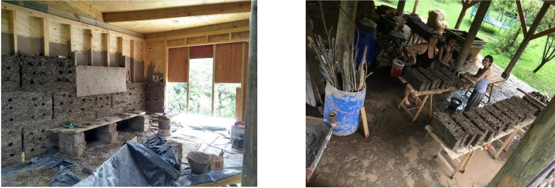
Figura 5. Paneles de madera con relleno de tierra alivianada encofrada y producción de BTA (crédito: M. M. Martínez, 2019)
