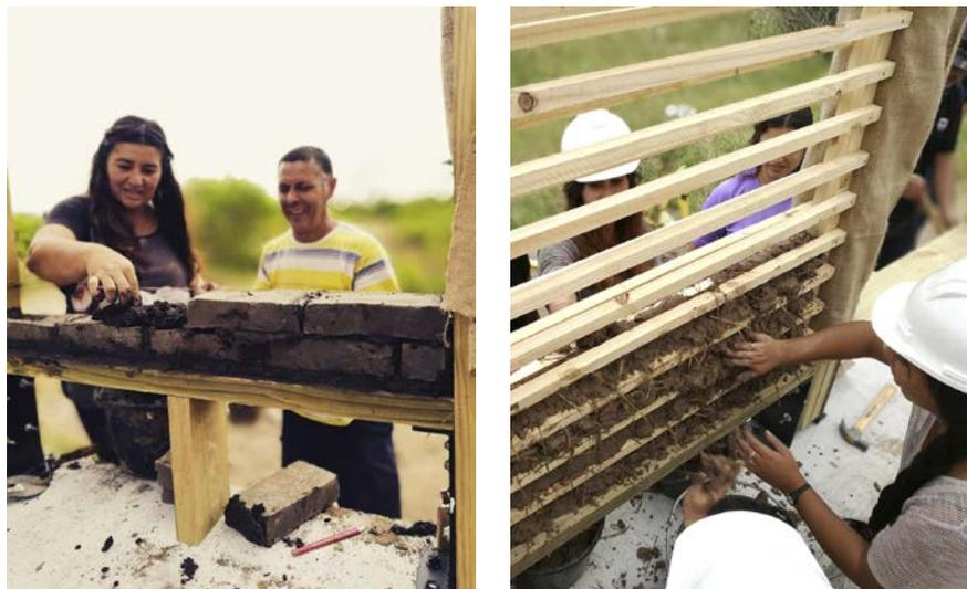
Figura 3. Proceso de construcción de los paneles de adobe y de fajina (crédito: equipo docente)
