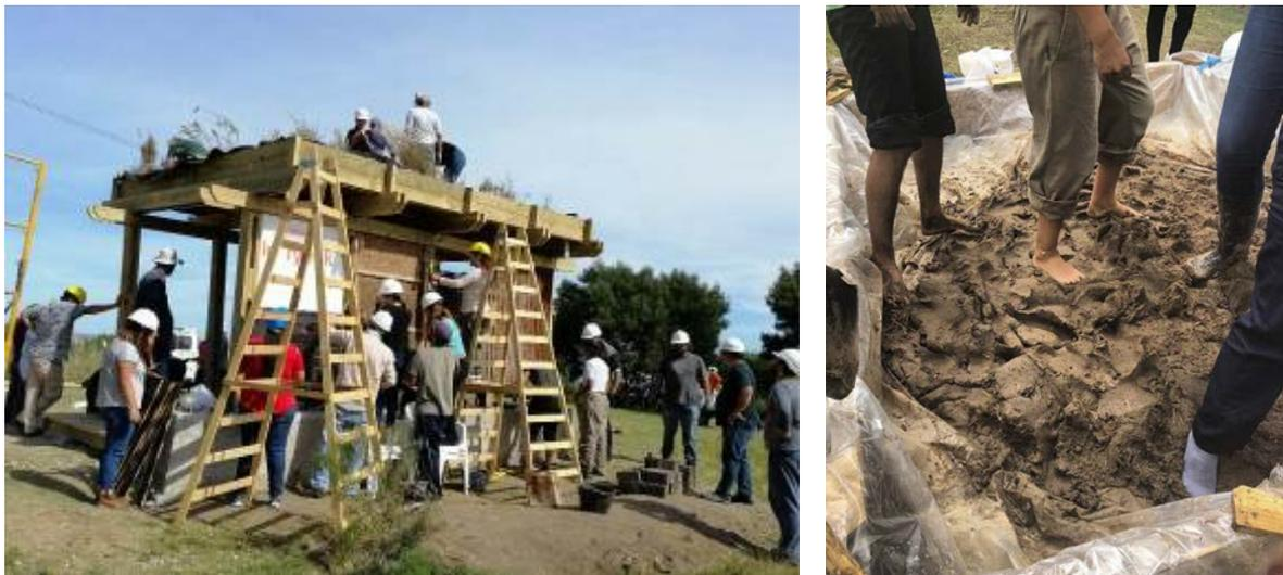
Figura 2. Construcción del prototipo. Colocación del techo vivo, cierre de los paneles verticales y trabajo en el pisadero (crédito: equipo docente)
