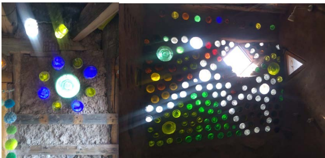
Figura 2: La figura muestra un muro de quincha con la estructura de madera y los materiales reciclados como las botellas
