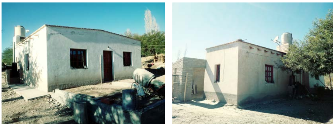
Figura 5. Viviendas ejecutadas a través del PROMEVI en La Fronterita, Los Zazos
