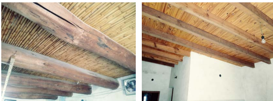
Figura 6. Variables de distintos casos de techo de torta de barro, respecto a la definición del envigado y cielorraso
