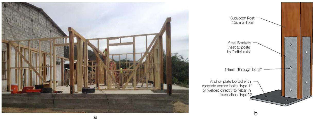
Figura 4. a) Sistema estructural de vigas y pilares de madera; b) Anclaje metálico (crédito: E. Wenz)
