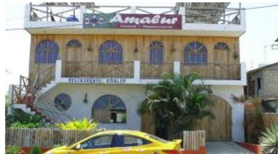
Figura 1. a) Hotel Royal Pacific, estructura de hormigón armado; b) Hotel Amalur, planta baja de ladrillo y columnas de hormigón, planta alta de madera (crédito: S. Hannen, abril 2016)
