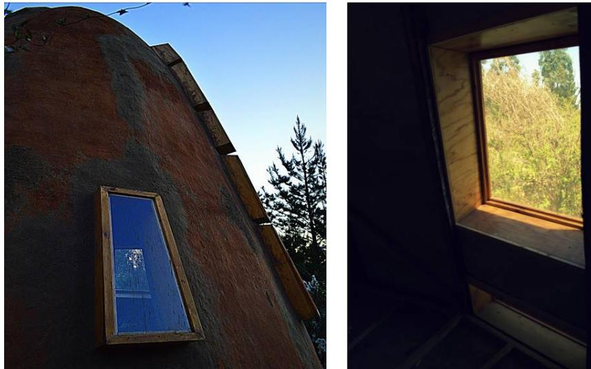
Figura 8. Detalle de la fachada noreste, recubrimientos de grietas por retracciones en alféizar de ventana y grietas por sismo. Figura adyacente; detalle del interior, sector oeste
