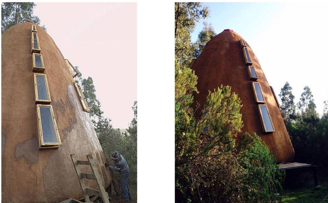
Figura 6. Aplicación del sello del revoque alisado en pleno invierno y terminación final
