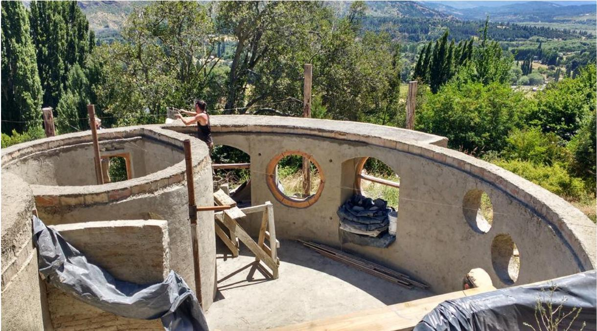
Figura 6. Obra de la vivienda “Susurros del Viento” en el Hoyo, Chubut, Argentina. Terminación del rasado final del encadenado superior de la pared de adobe (crédito: M. Aresta)
