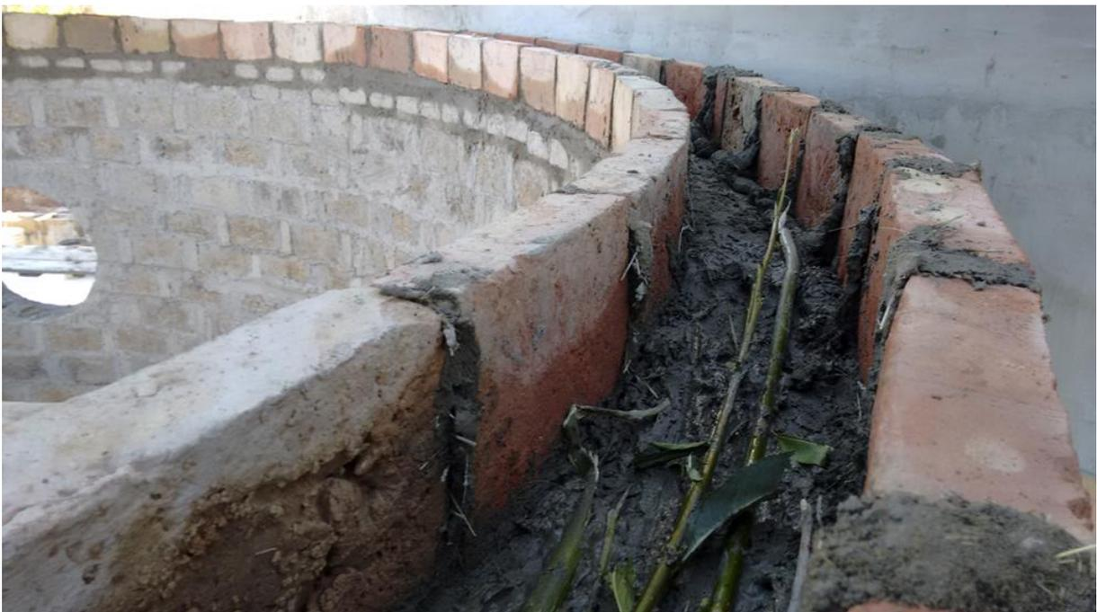
Figura 4. Construcción de un encadenado de sauce y barro con encofrado perdido de ladrillos (crédito: M. Aresta)
