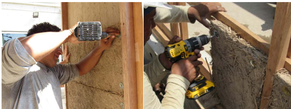
Figura 6. Atornillado de elementos en tierra alivianada en panel de quinchá (crédito: Archivo Proyecto Quinchá, 2018). Atornillado de elementos en TA en el sistema propuesto (crédito: Archivo de proyecto, 2019).
