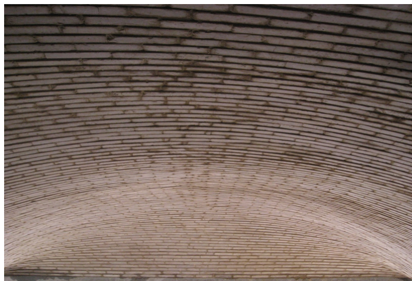
Figura 5 - Bóveda de ladrillo recargado para entrepisos
