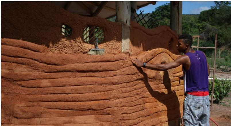
Figura 6. Colaborador local realizando a etapa de revestimento em paredes de terra ensacada durante a construção da Estação Natureza
