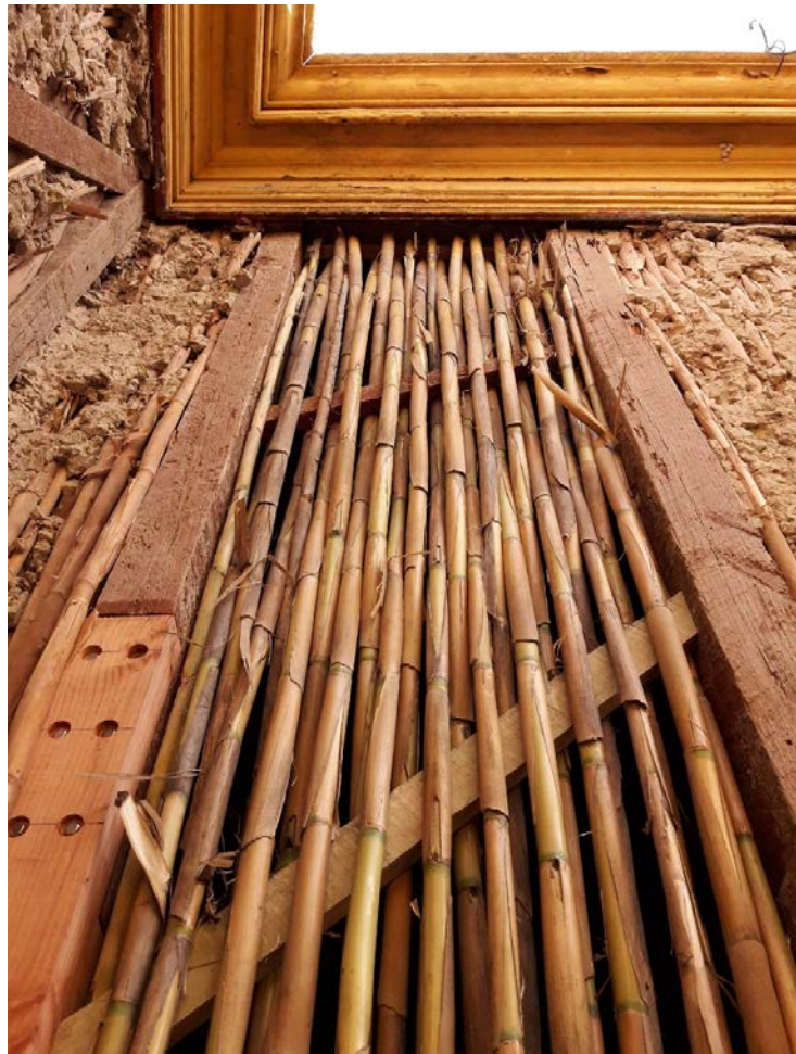
Figura 5. Vista de restitución de quinchas con cañas en Casa Copaja. (Crédito: C. Giribas)
